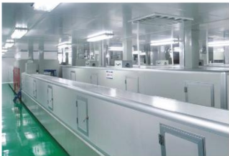
全封闭喷涂线
